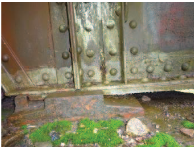
Pevné tangenciální ložisko levého nosníku na opěře O02, vnější strana
