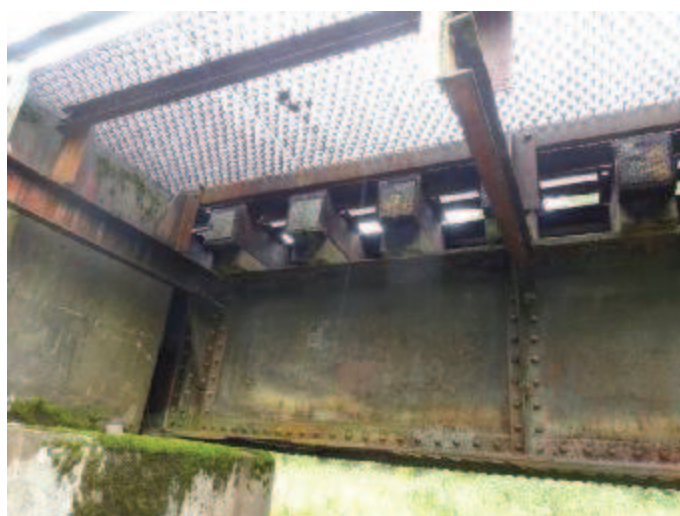
Dřevěné mostnice jsou uloženy na horní přírubě nosníků
