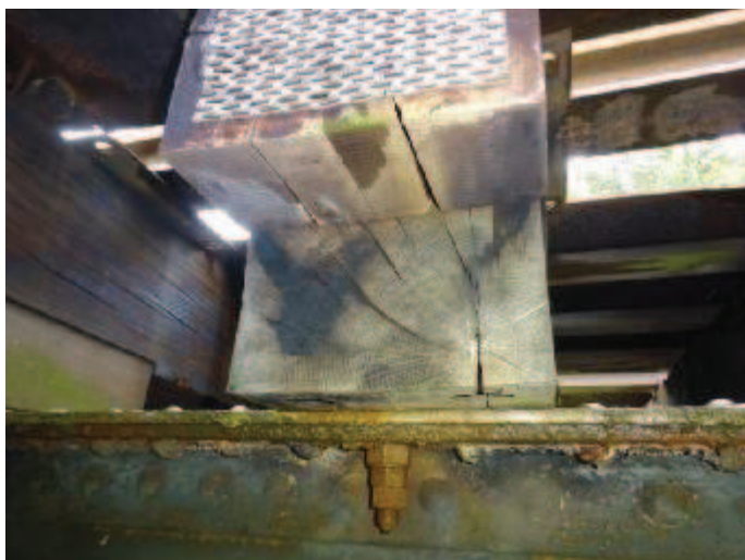
Trhliny v dřevěných mostnicích
