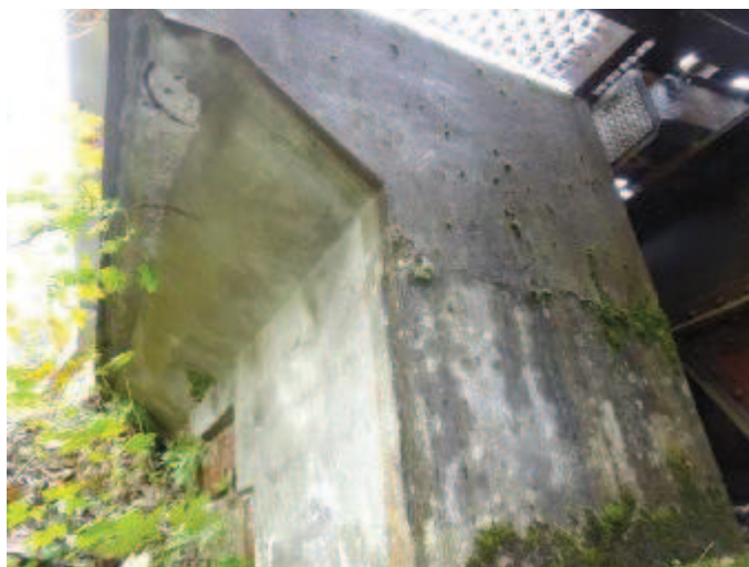
Počínající koroze betonářské výztuže
