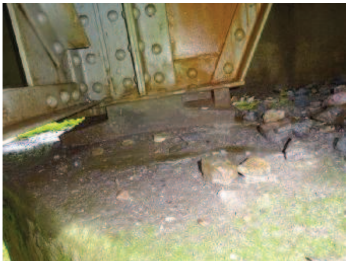
Pevné tangenciální ložisko levého nosníku na opěře O02, vnitřní strana
