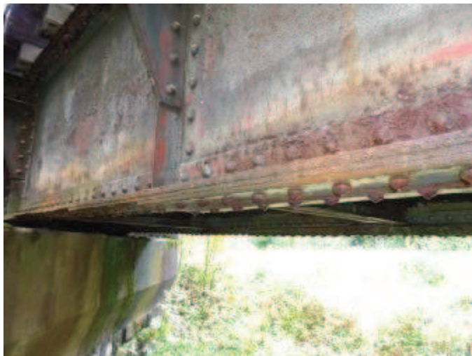
Odlupující se nátěry, povrchová koroze
