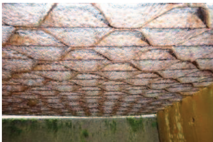
Významné poškození ocelových roštů korozí
