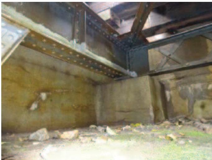
Podružné ložisko a kolmý závěr na opěře O02
