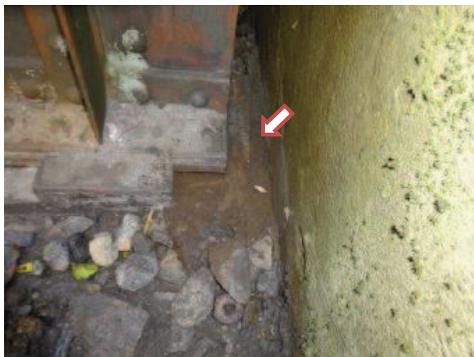
Utržená zarážka pevného tangenciálního ložiska pravého nosníku nad O02
